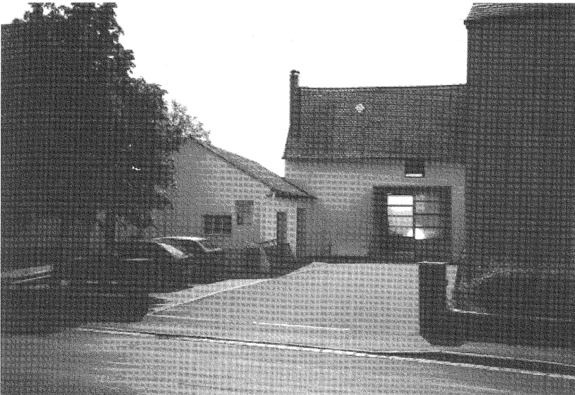
Photo 7: Umnutzung ehemaliger Hofgebäude als Flaschner- und Bauschlosserei. (Großenseebach, Photo: B. Ciolek)
