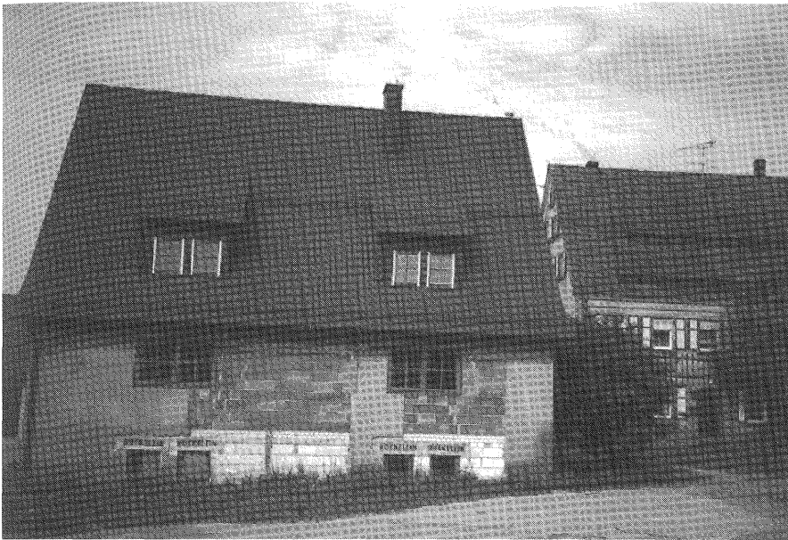
Photo 4: Umbau einer ehemaligen Scheune in ein Wohnhaus. (Eckenhaid, Photo: B. Ciolek)
