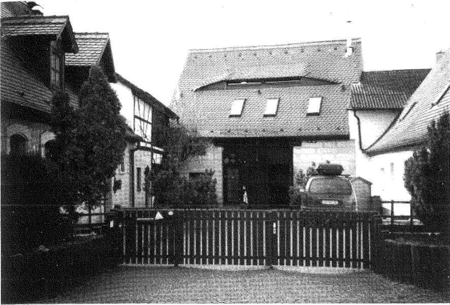
Photo 1: Umbau eines denkmalgeschützten Hofes in Wohnungen (Scheune und Stall). (Neuhaus, Photo. B. Ciolek)
