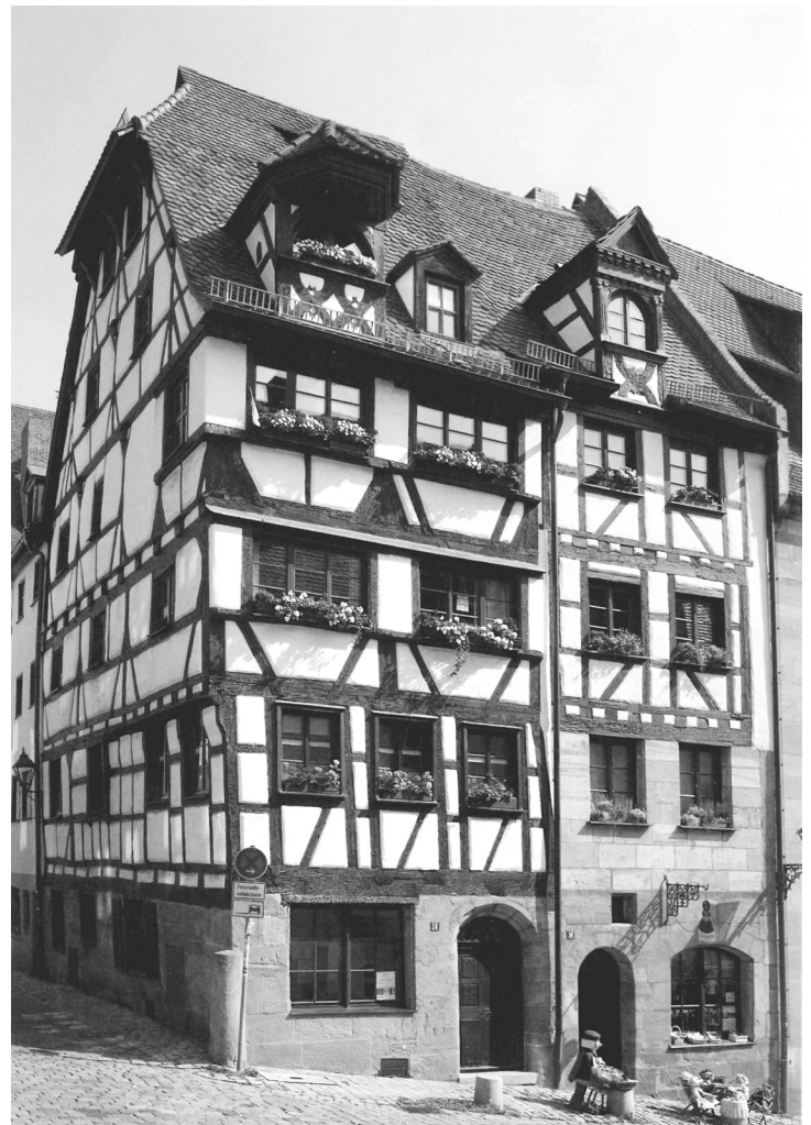
Abb. 3: Die beiden Häuser Untere Krämersgasse 16 und 18 sind die ersten Gesamtsanierungen der Altstadtfreunde (1976–77 bzw. 1975–82). Ihre Steildächer, die Dacherker, die Sprossenfenster und die freigelegten Fachwerkfassaden werden vom Verein der Altstadtfreunde als typisch für Nürnberg erachtet. (Quelle: HAHN 2014: 92 ff.)
