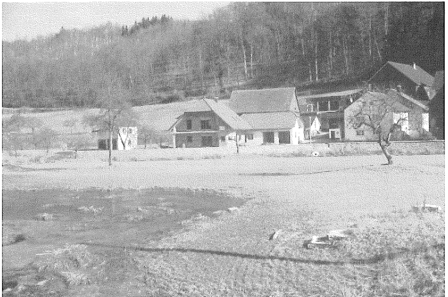
Abb. 21: Hochwasserfreilegung an der Leinleiter in Traindorf
