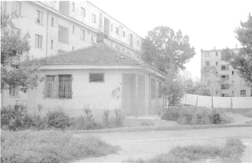
Foto 1: Aufgestocktes (staatliches) Mehrfamilienhaus in Tirana
