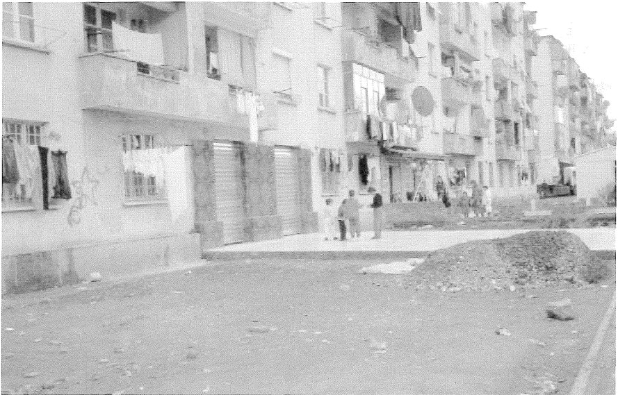
Foto 6: Ladengeschäfte in umgebauten Erdgeschosswohnungen in Tirana
