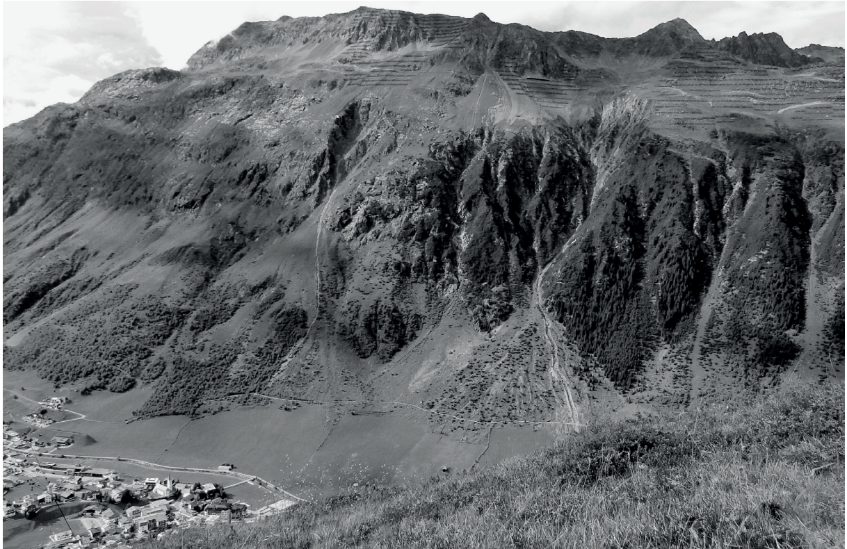
Foto 1: Der Hauptort Galtür mit Blick von Südosten auf die Lawinerverbauungen am Grieskogel (Aufnahme S. Scharpff 2014)
