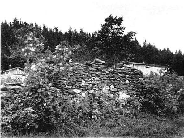
Abb. 5. Scheibenhof am Scheibensattel: Im Vordergrund Mauerreste des wüstgewordenen Bauernhofes; dahinter das heute von einem Waldaufseher bewohnte, frühere Inhaus. (Aufnahme 1937)
