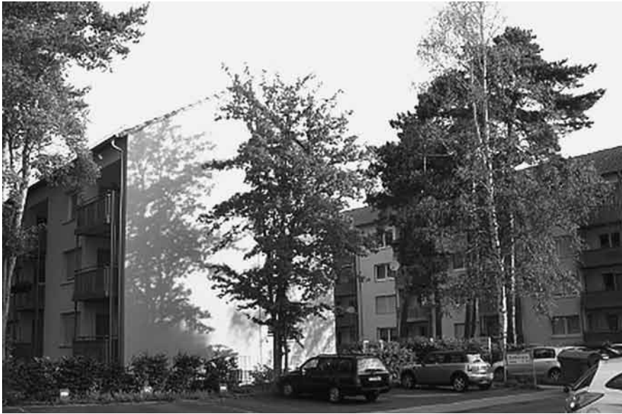
Foto 7: Kürzlich saniertes Gebäude in der Zeißstraße (Aufnahme: A.-L. Müller)
