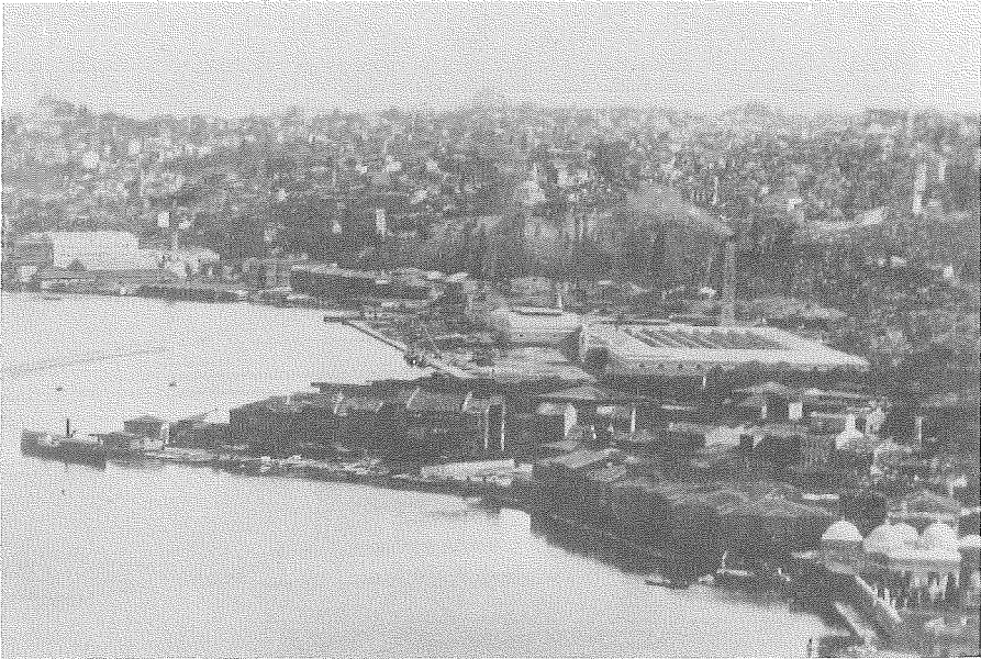
Bild 13. Ausschnitt aus einer Stadtansicht von 1883 mit der Baustelle des Feshane (DAI Istanbul Neg. Nr. R 24930)
