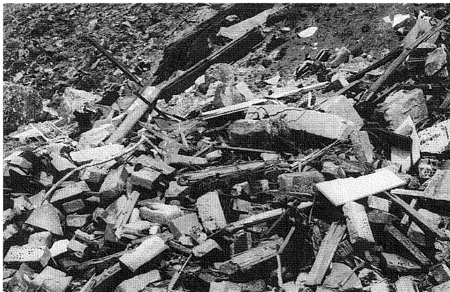
Abb. 2: Ein klarer Verstoß gegen das bestehende Abfallrecht: grob verunreinigte, "mineralische" Restmassen auf der Bauschuttdeponie
