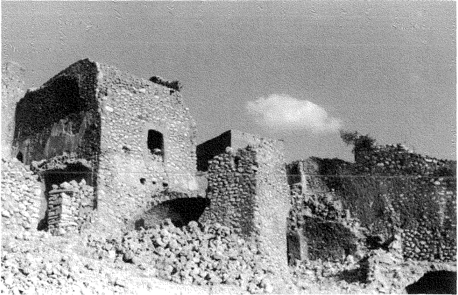
Abb. 24: Balad Sinjar. Verfallende Stadtmauern. Darüber Wohnhäuser aus Bruchstein-Mauerwerk
