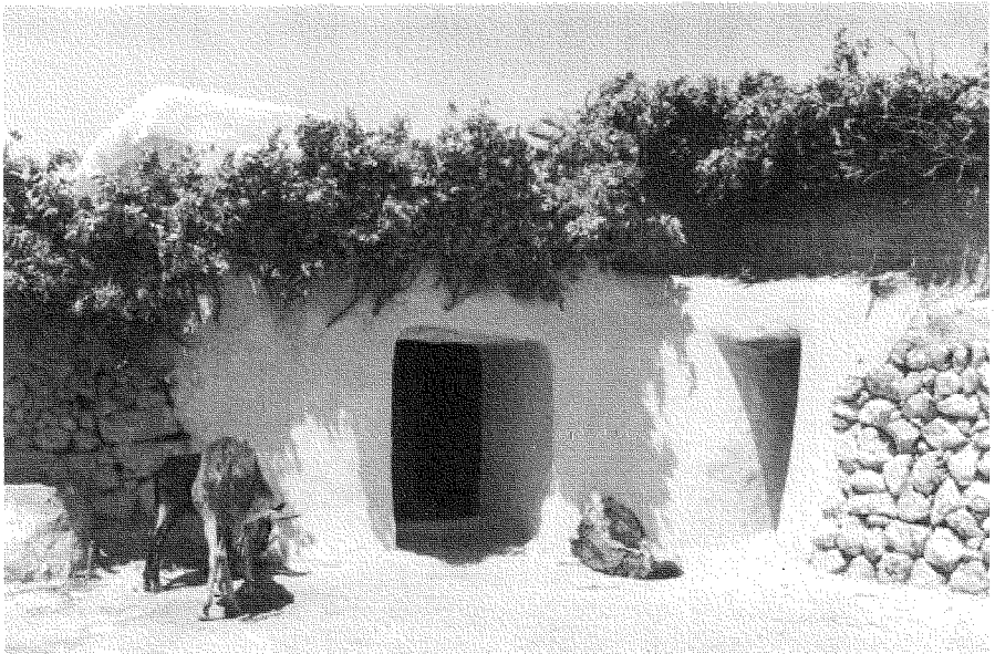
Abb. 21: Gehöft mit Eingangstrakt aus verputztem Bruchstein-Mauerwerk und Reisig auf dem Dach
