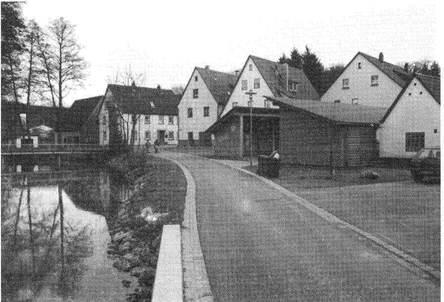
Abb. 9: Aurachsteg und rechte Uferseite mit Carports
